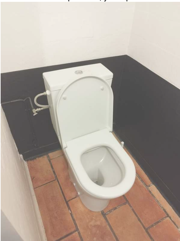
Sanitaires existants - non conformes PMR
